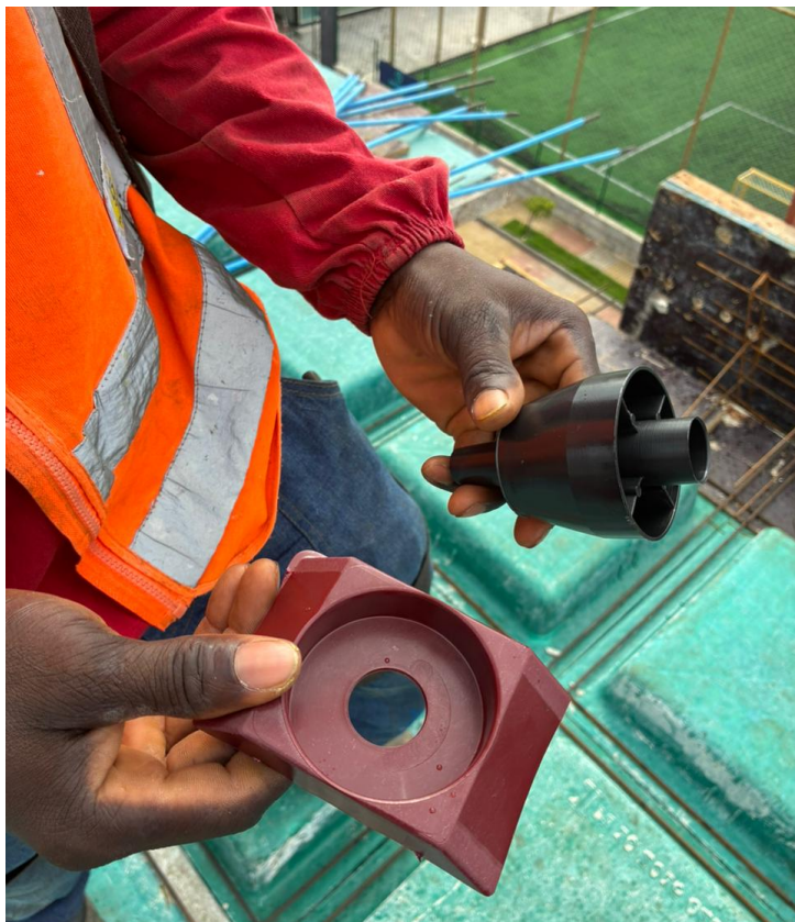
浇筑前 / 现场组件
