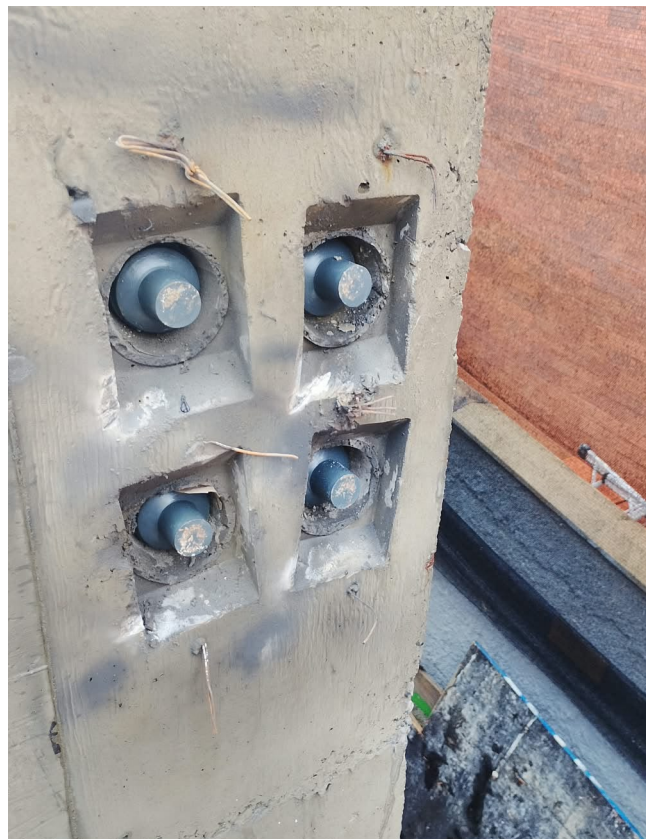
CAP / 凹槽封闭前
